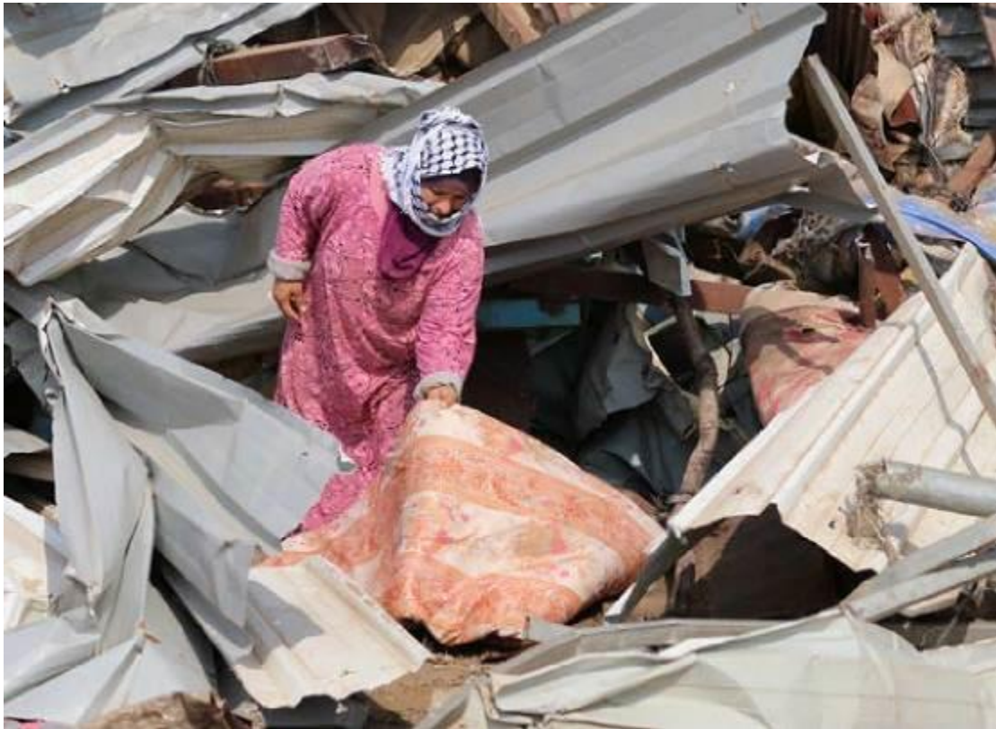
Eine palästinensische Frau begutachtet die an ihrem Haus verursachten Schäden, nachdem die israelischen Streitkräfte es am Vortag in der Ortschaft Al-Hadidiya im Jordantal im besetzten Westjordanland zerstört hatten, am 11. Oktober 2018. Der Abriss erfolgte, weil die israelische Genehmigung für den Bau des Gebäudes fehlte. © Active Stills
